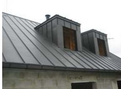
Figure 15 : Toiture en zinc
