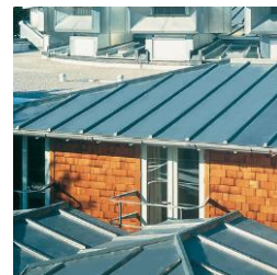
Figure 58 : Couverture en zinc à tasseaux
