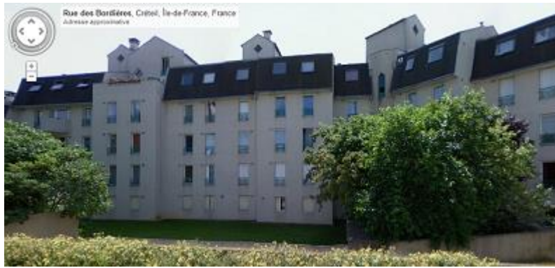
Figure 89 : Réhabilitation du Centre Ancien – Quartier La Bordière : ajouts des éléments en bardeaux bitumeux aux toits-terrasses bi-pentes
