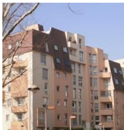
Figure 92 : Exemple des toitures-terrasses avec des brisis en bardeaux bitumineux- Quartier L'Ormetteau
