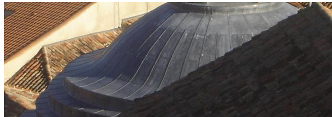
Figure 13 : Toiture ancienne de la Cathédrale El Burgo d'Osma (Espagne) en plomb
