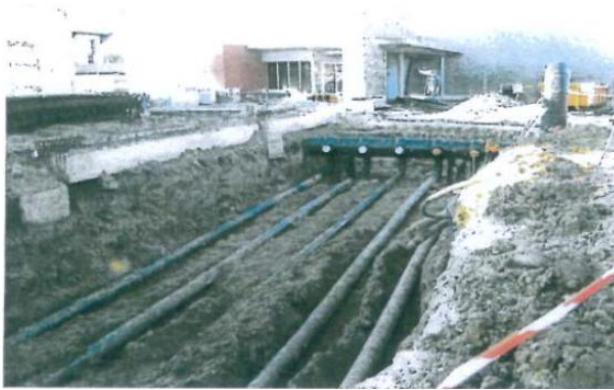
Figure 1. 11 : Photographie d'un puits climatique installé dans le Lycée Pape Clément à Pessac (33)
