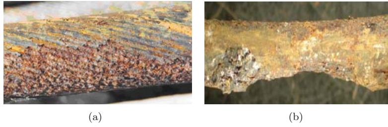
FIG. 3.13 – Endommagements liés à la corrosion
