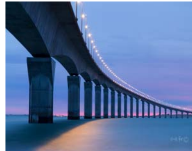
(c) Pont de l'Ile de Ré (Béton précontraint)
