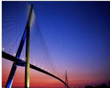
(b) Pont de Normandie (Pont à haubans, câbles monotorons)
