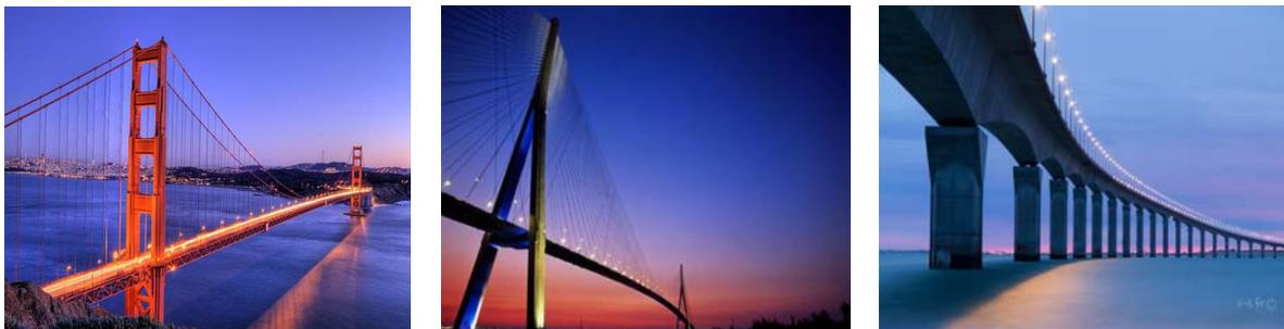
(a) The Golden Gate Bridge (Pont suspendu, câbles monotorons) (b) Pont de Normandie (Pont à haubans, câbles monotorons) (c) Pont de l'Ile de Ré (Béton précontraint)
