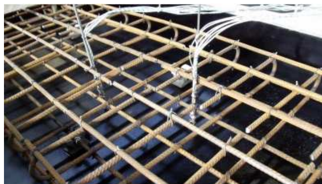
Figure 7.7. Implantation de deux échelles de thermocouples à boule dans le ferrailage
