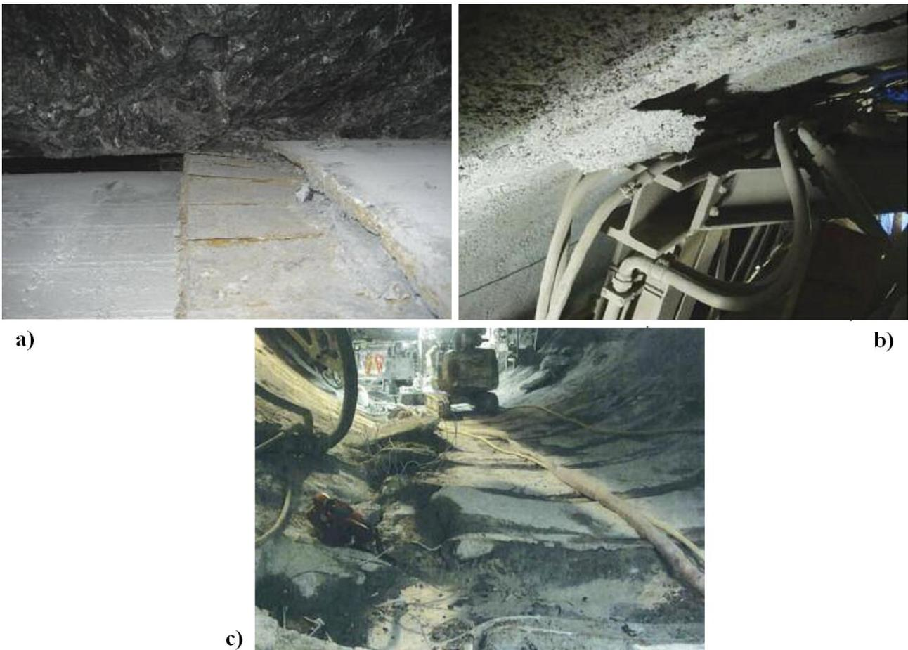
**Fig. 1.3** a) blocage du bouclier (tunnel de Uluabat) b) blocage du train suiveur (tunnel du Gotthard) c) rupture des voussoirs (tunnel du Gotthard) (Ramoni et Anagnostou 2012).
