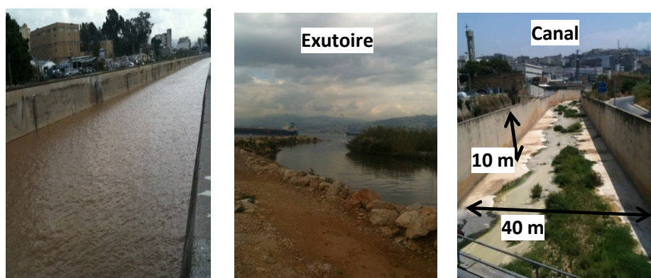
Figure 14. Canal du fleuve Beyrouth dans sa partie aval
