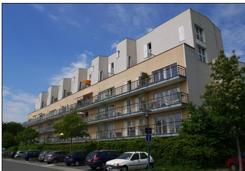
Figure 52 : L'immeuble Salvatierra à Beaugard
