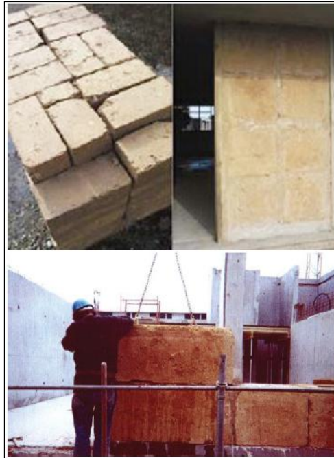
Figure 53 : Des murs en bauge et bois
