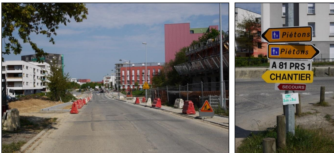
Figure 77 : L'omniprésence des chantiers de construction dans le quartier
