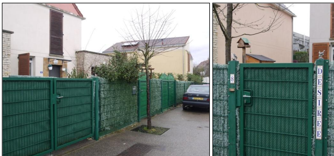
Figure 73 : Renforcement des pare-vue et des seuils dans les logements en accession à la propriété
