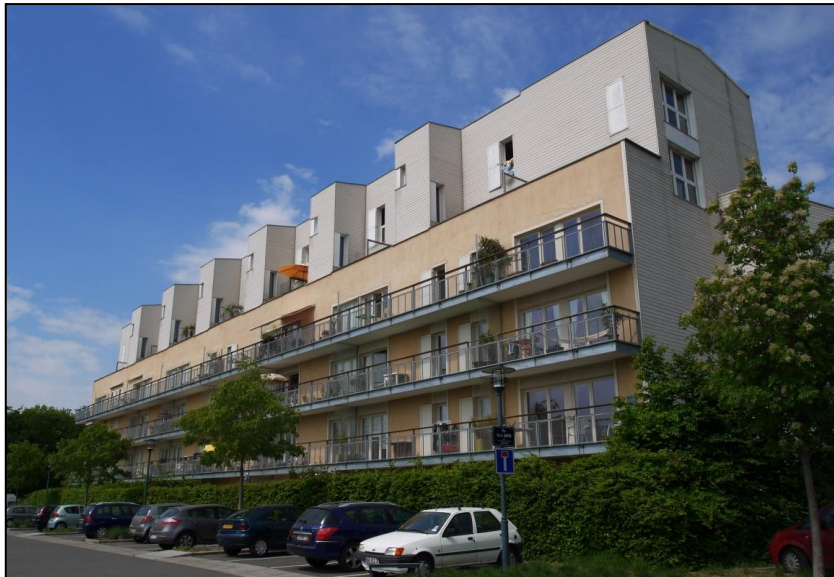
Figure 52 : L'immeuble Salvatierra à Beauregard
