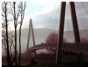
FIGURE 1.7 – Passerelle d'Aberfeldy, Ecosse, suspensions constituées de faisceaux de fibres de Kevlar<sup>®</sup>29, Sarah Ellis/Hutchinson Library.
