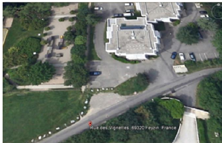
Figure 252 : Vue aérienne du bâtiment
