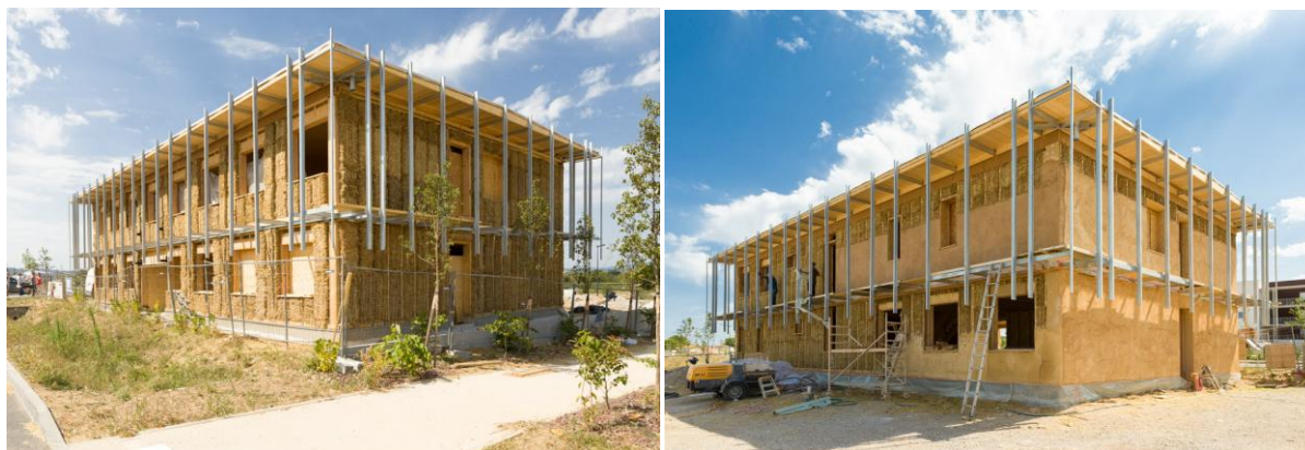
Figure 91 : Mise en œuvre de la paille (à gauche) puis couverture par l'enduit à la chaux (à droite)
