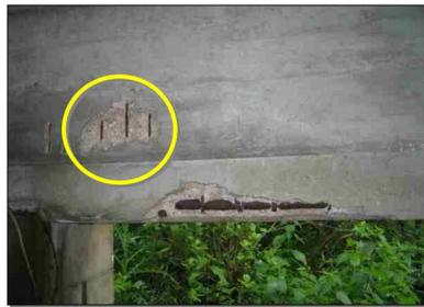
(b) Fissuration d'une poutre et écartement du béton
