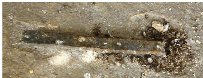
figure 33 : Excréments animaux sur une agrafe de la tour de la Mutte de la cathédrale de Metz
