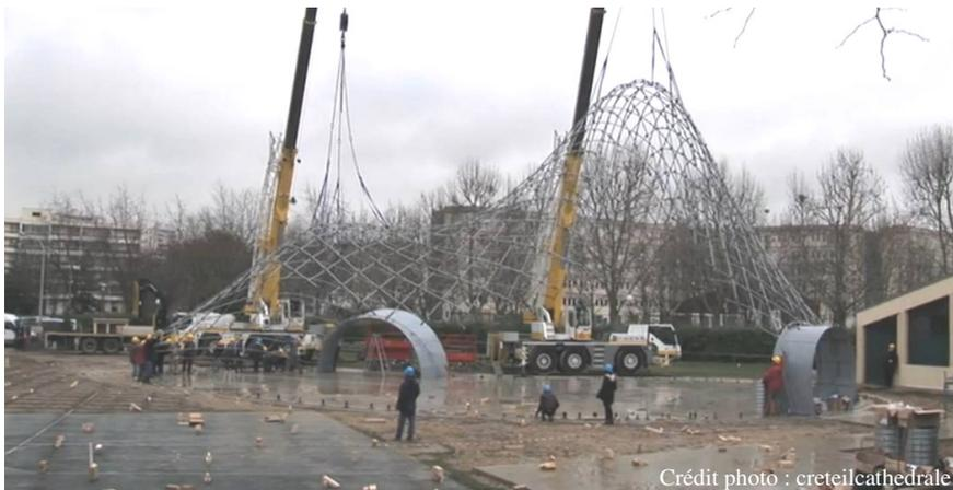
**Figure 1.4 - Déploiement puis ancrage de la grille**
