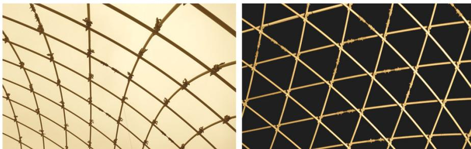
**Figure 1.5 - Triangulation du gridshell**
