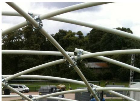
**Figure 2.41 - Raboutage utilisé**
