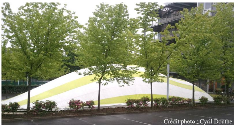
**Figure 2.16 - Premier prototype de gridshell en matériaux composites**
