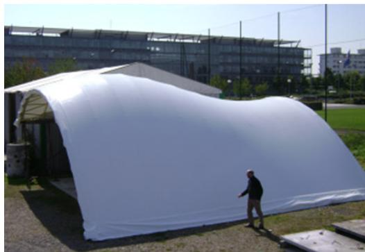
**Figure 2.18 - Prototype de gridshell couvrant la soufflerie de l’ENPC**
