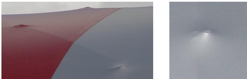
Figure 2.42 - Marquage de la membrane par les boulons
