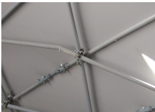
**Figure 2.66 - Rupture de tube dans la nappe inférieure**
