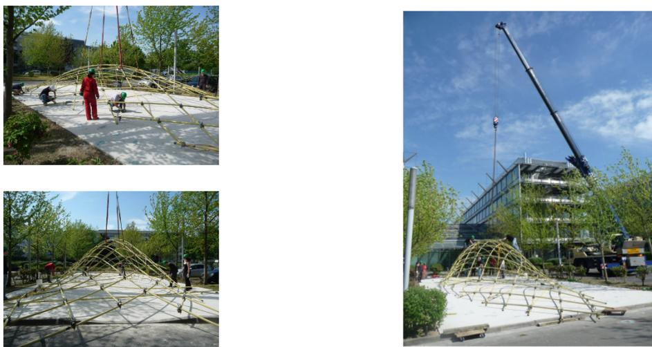
**Figure 2.14 - Deuxième déploiement du gridshell test**
