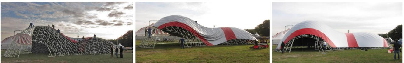
**Figure 2.35 - Déploiement de la membrane par Esmery Caron**
