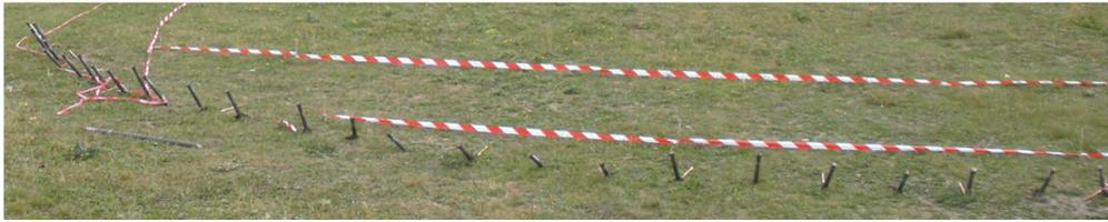
**Figure 2.29 - Ancrages une fois mis en place**
