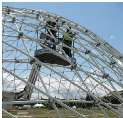
**Figure 2.33 - Triangulation du gridshell à l'aide d'une nacelle**
