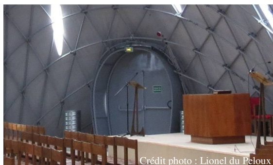
Figure 2.63 - Porte métallique garantissant étanchéité et sécurité
