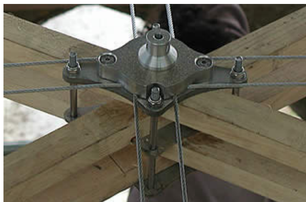
Figure 2.39 - Triangulation par câble similaire à celle utilisée pour le gridshell de Mannheim
