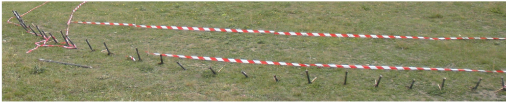
Figure 2.29 - Ancrages une fois mis en place
