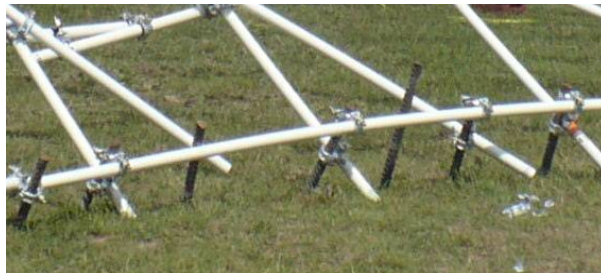
Figure 2.34 - Mise en place de la rive sur les ancrages
