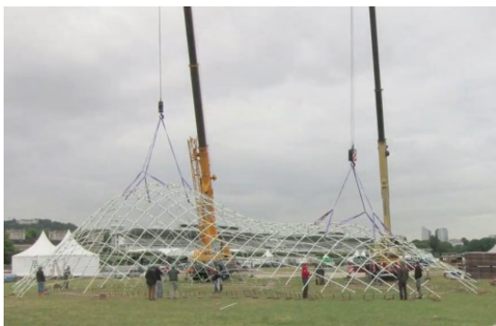
Figure 2.32 - Déploiement du gridshell
