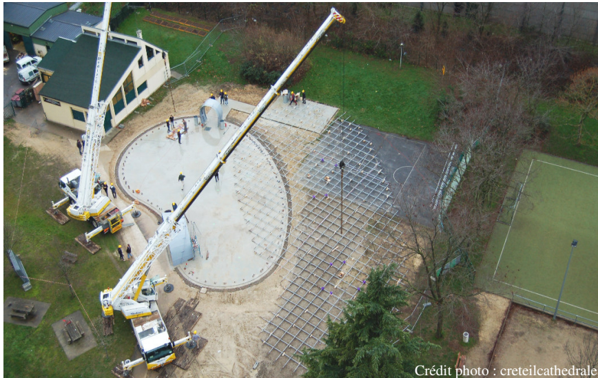
Figure 1.3 - Assemblage de la grille primaire à plat sur le site de construction
