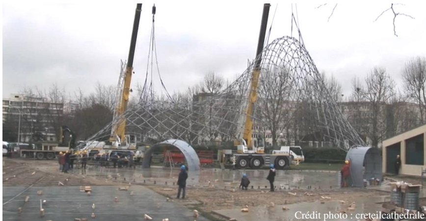
Figure 1.4 - Déploiement puis ancrage de la grille
