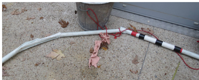
Figure 2.58 - Endommagement de la poutre raboutée
