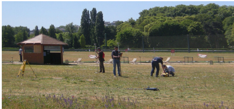
Figure 2.28 - Repérage des points d'ancrage par les géomètres
