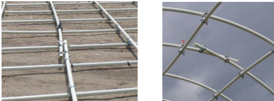
Figure 2.40 - Un raboutage problématique
