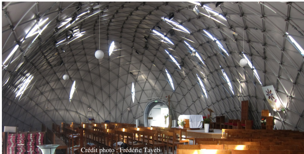
Figure 2.64 - Vue intérieure du gridshell
