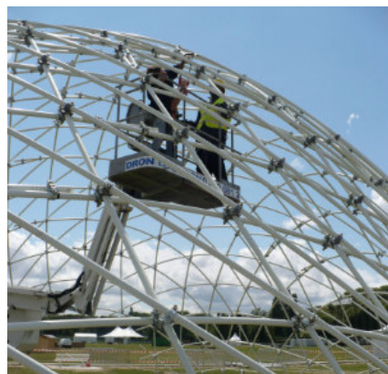
Figure 2.33 - Triangulation du gridshell à l'aide d'une nacelle
