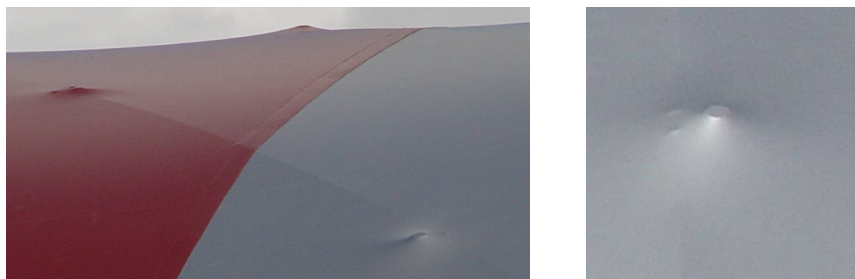
Figure 2.42 - Marquage de la membrane par les boulons
