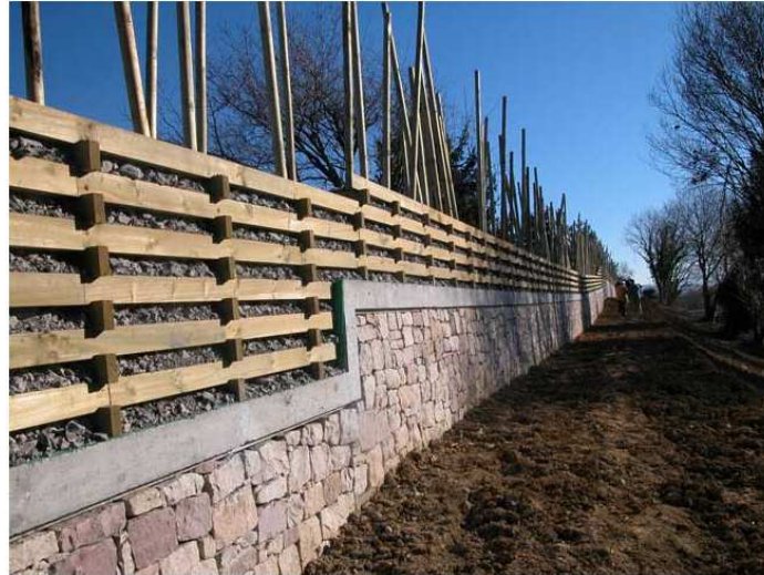
Figure 1-9 : Parement en bois, autoroute A36 (crédits Terre Armée)
