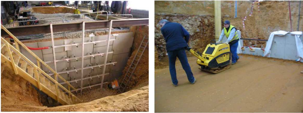
Figure 2-2 : Construction du mur expérimental dans la fosse du CER (d'après [SOY09])
