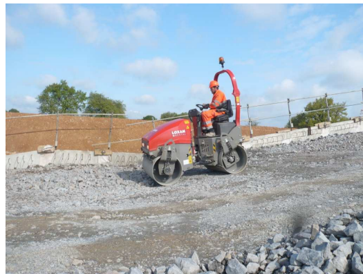
Figure 1-2 : Mise en place du lit d'armatures / Figure 1-3: Compactage d'une couche de remblai
