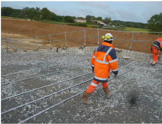
Figure 1-2 : Mise en place du lit d'armatures / Figure 1-3: Compactage d'une couche de remblai
