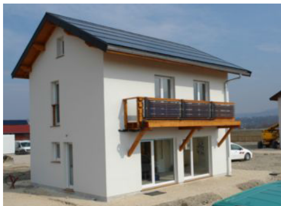
Figure 31 : Maison I-BB (façades sud et ouest)
