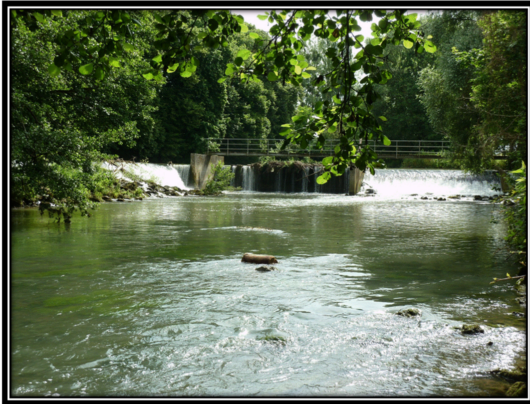
Figure 12 : Ouvrage sur le Grand Morin.
