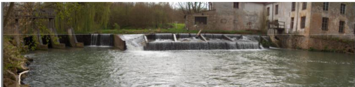
Figure 61 : Déversoir du moulin du Pont sur le Grand Morin. (Source : Philippe Busch).
