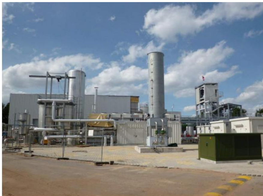
Figure 18 : Photographie de l'usine Power To Gas Audi e-Gas (Etogas, 2013)
