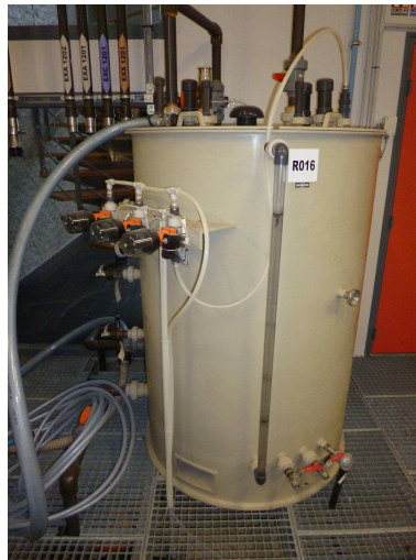
Figure 26 : Cuve de 1 m3 pour la récupération d'eau issue de la laverie et de douches
