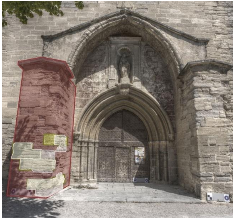
Figure 139 : Superposition de trois annotations pour la recherche de corrélation [Messaoudi T. et al, 2015] : en rouge, élément architectural : contrefort, en jaune, matériau : pierre jaune de Caromb, en blanc, altération : alvéolisation
