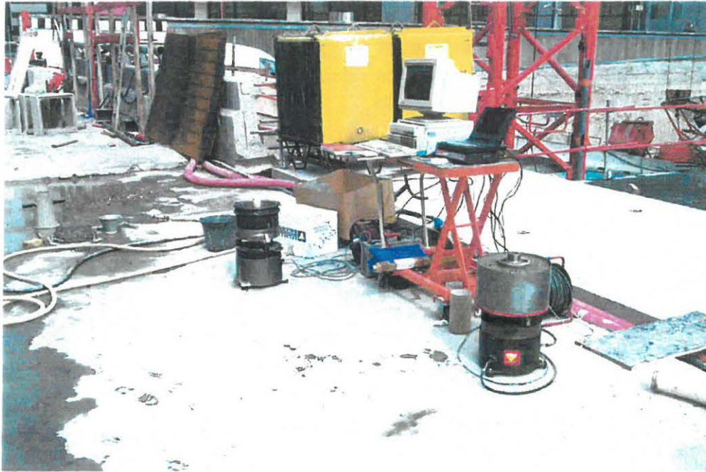
Figure VII.2 – Essais sur le béton (chantier "Cœur Défense").
