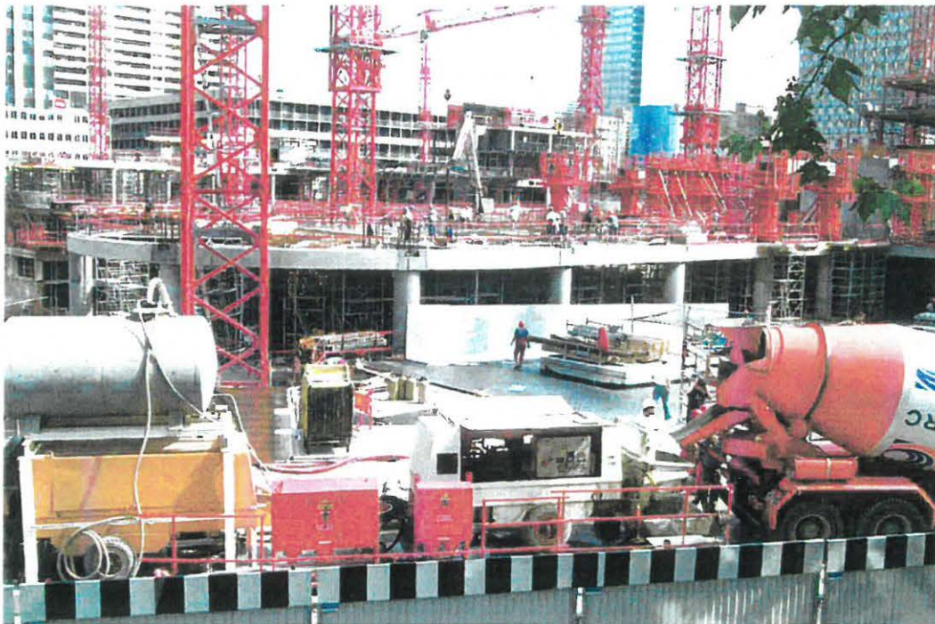
Figure VII.1 – Chantier "Cœur Défense".
