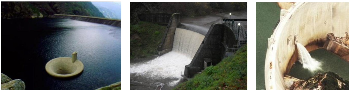
Figure 4 : Déversoir libre à crête circulaire de type « tulipe ». Déversoir à seuil libre. Evacuation d'eau par une vanne de vidange de demi-fond. (De gauche à droite ; source CFBR).
