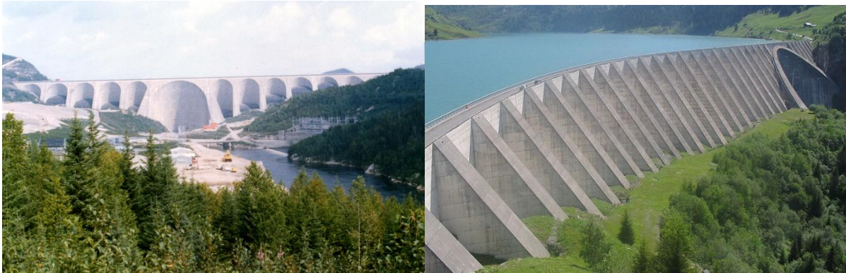
Figure 3 : Le barrage de Daniel-Johnson (à gauche) mesure 1 314 mètres de long et présente 13 voûtes, une principale au centre et 6 secondaires de chaque côté. Le barrage de Roselend (à droite) combine une voûte centrale et une série de contreforts pour une longueur de 804 mètres (libre de droit).
