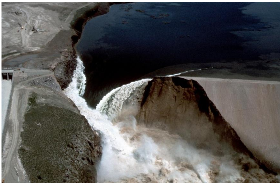
Figure 16 : Photo de la brèche ouverte en rive droite du barrage de Grand Teton, en référence d'échelle la partie intègre du barrage, visible en bas à droite, mesure 93 mètres (source : IDAHO-L-0010 by WaterArchives.org - Sacramento, California, USA).
