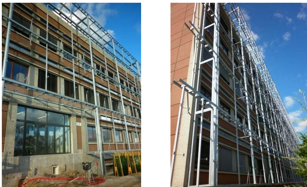
Figure 4.19. Chantier d'une façade double peau vitrée dans le campus de l'Université de Bordeaux.
