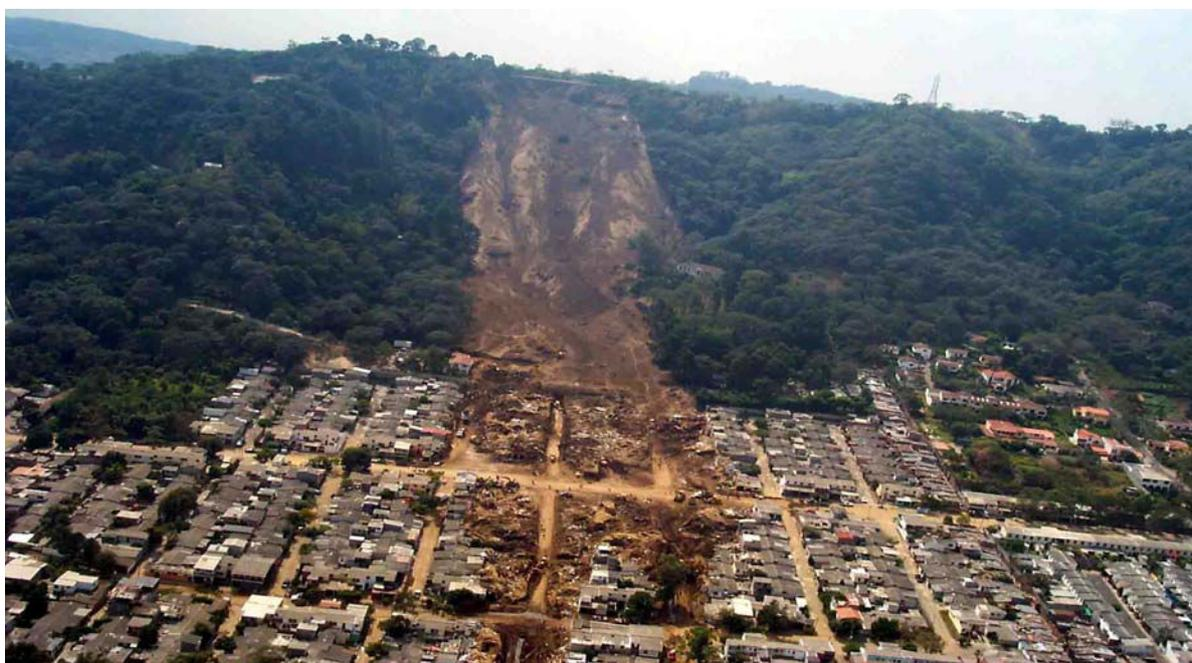
**Figure 9.** Glissement de Las Colinas (El Salvador, Amérique Centrale) déclenché par le séisme du 31 janvier 2001, Mw=7.6 (cliché USGS)
