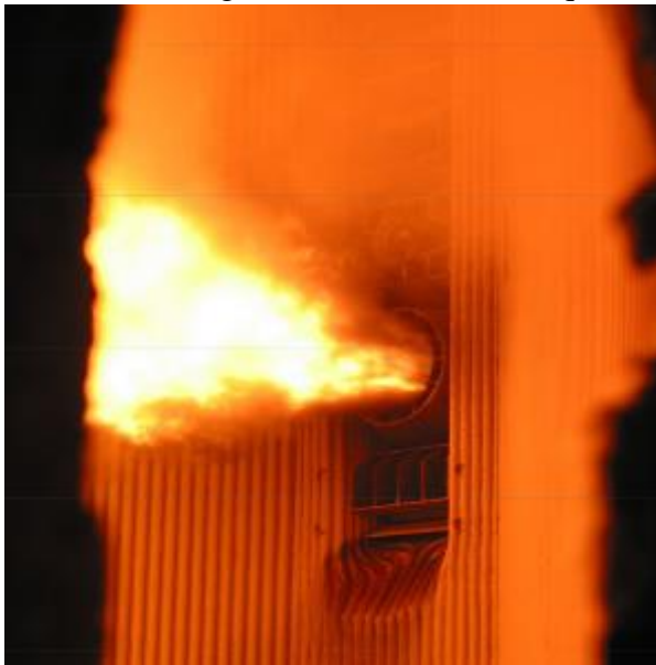
Figure 5 : Photo d'un brûleur à charbon pulvérisé installé dans une chaudière
