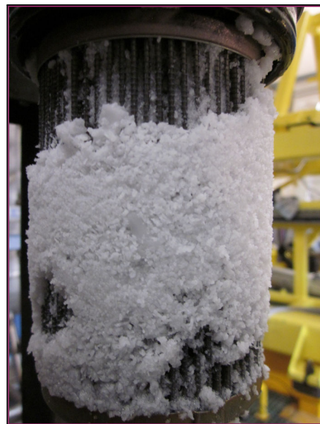
FIGURE 9.14 – Dépôt de glace sur un élément filtrant.
