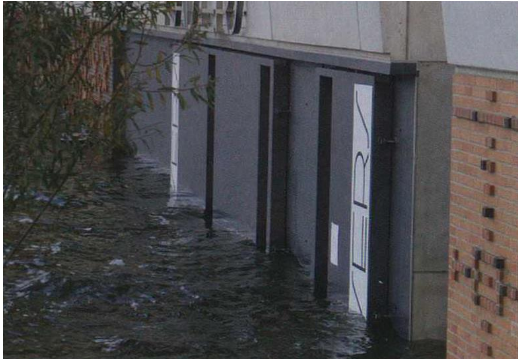
Figure 61 Portes de protection contre les crues, Hambourg. Source: Michael Klessmann, Bauwelt 1-2.08
