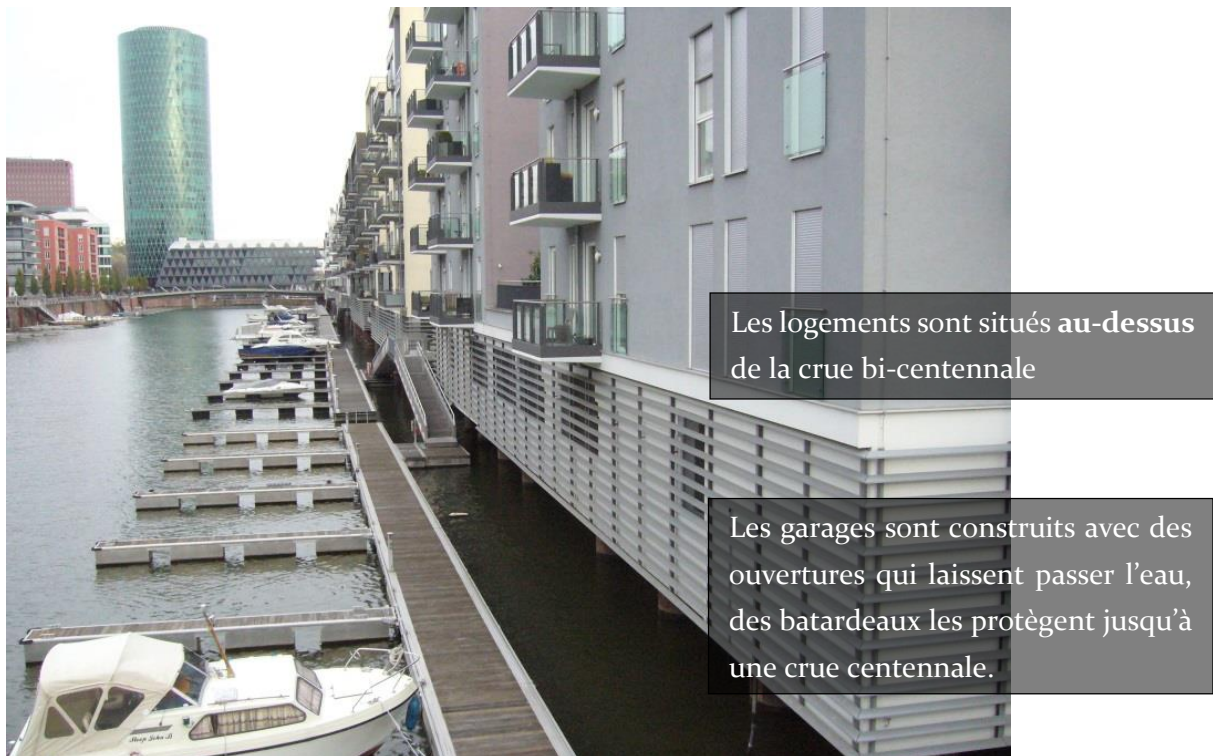
Figure 25 La construction des immeubles dans Westhafen, Francfort-sur-le-Main Source : Elodie Moulin, 2013
