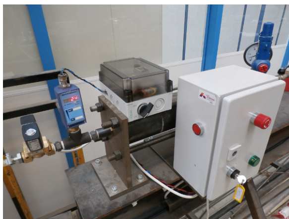
FIGURE D.13 – Vue d'ensemble de la commande du dispositif de chargement.
