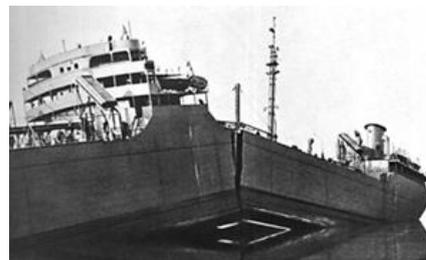
**Figure 1 : Gauche : Fissuration dans une œuvre porcelaine de Geyao du 12<sup>e</sup> siècle. Droite : rupture dans le cargo American de la deuxième guerre mondiale**
