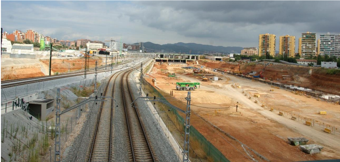
Photographie 10- Chantier de la Sagrera en septembre 2013
