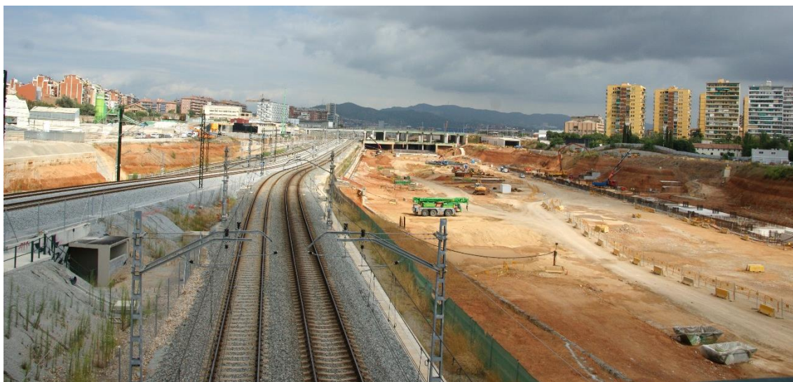
Photographie 10- Chantier de la Sagrera en septembre 2013
