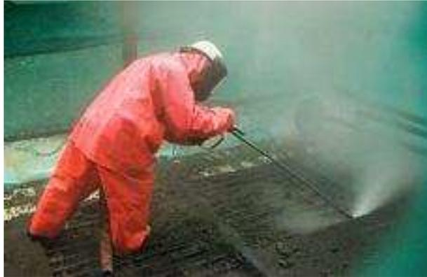
Illustration 6 : Démolition par jet d'eau à haute pression (hydrodémolition),
