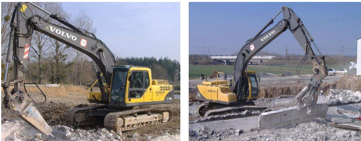
Illustration 1 : La démolition mécanique (BRH à gauche et pince à béton à droite),
