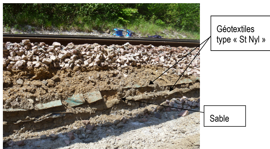
Figure I.7 : Assainissement de plateforme par sable et géotextiles
