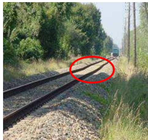
Figure I.17 : Photo d'une zone de défaut de portance
