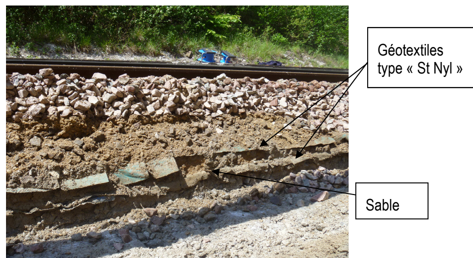
Figure I.7 : Assainissement de plateforme par sable et géotextiles
