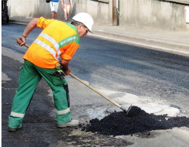
Figure 6 : Mise en œuvre manuelle autour d'un regard (Chantier Eurovia)
