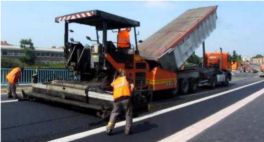
Figure 5 : Mise en œuvre mécanisée à l'aide d'un finisseur (Chantier Colas)
