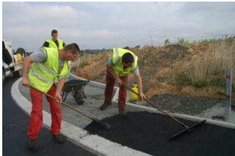
Figure 7 : Mise en œuvre manuelle après déversement à la brouette (Chantier Colas)
