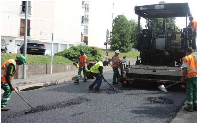
Figure 8 : Finitions manuelles après le passage du finisseur (Chantier Eurovia)
