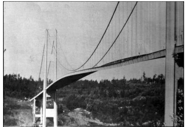
(b) Instabilité de flottement sur le pont de Tacoma et responsable de sa destruction.
