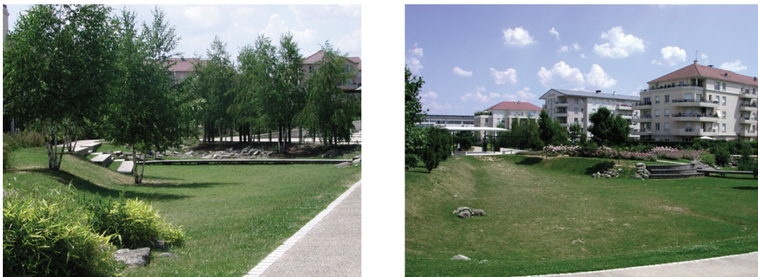
Figure 1.8 – Exemples (à Noisy le Grand) de stockage à l'air libre dans des espaces paysagés (Source: Bressy, 2010)
