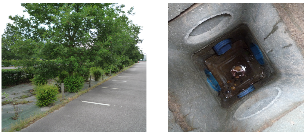
Figure 1.13 – Exemple de noue drainée (à Rouen). A gauche vue générale de l'ouvrage. A droite : arrivée des drains au niveau d'un regard (Source: M-C. Gromaire)
