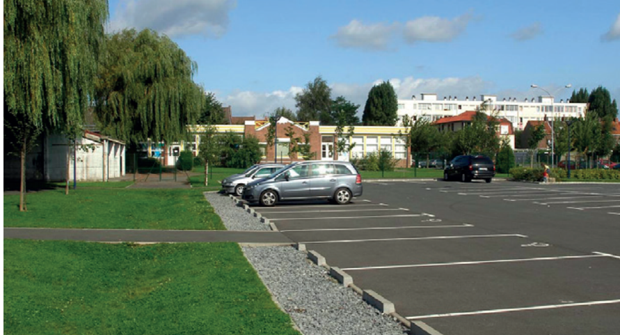
Figure 1.9 – Exemple (à Pérenchies) de tranchée d’infiltration avec stockage dans des graves (Source: LM, 2012)
