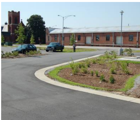
Figure 1.10 – Exemples (en Caroline du Nord) de système de « bioretention » avec stockage dans une couche de sol amendé (Source: Li et al., 2009)
