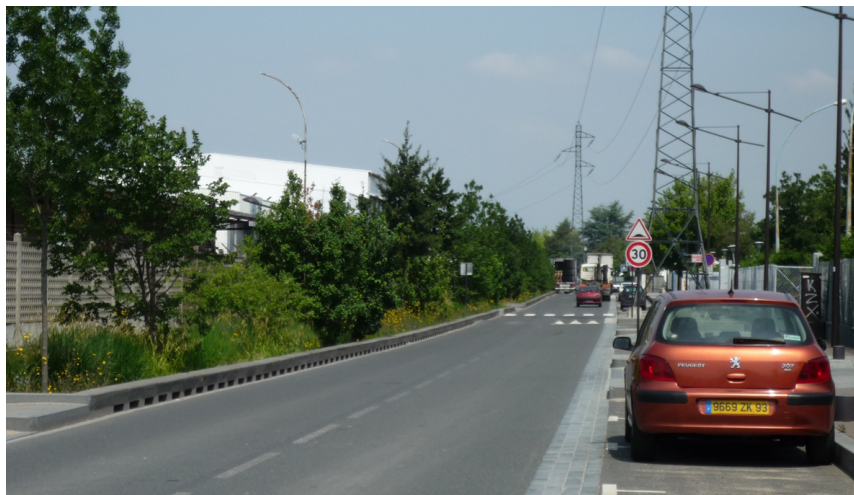
Figure 1.7 – Exemple (à Vitry sur Seine) d'alimentation diffuse d'une noue par ruissellement direct depuis l'accotement d'une chaussée avec une bordure ajourée (Source: M-C. Gromaire)
