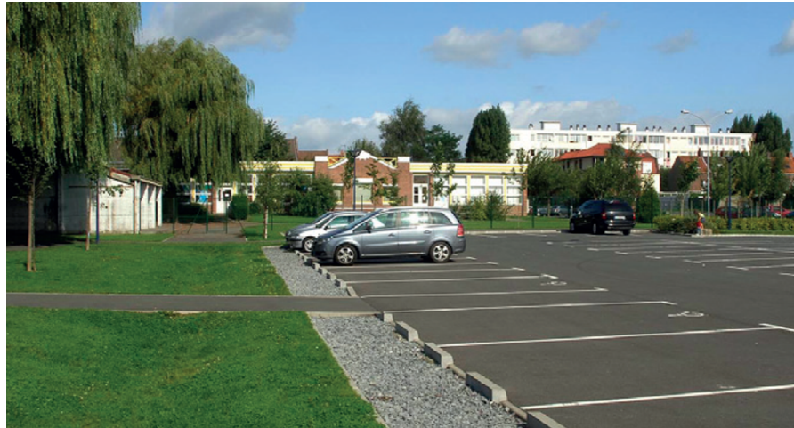
Figure 1.9 – Exemple (à Pérenchies) de tranchée d’infiltration avec stockage dans des graves (Source: LM, 2012)
