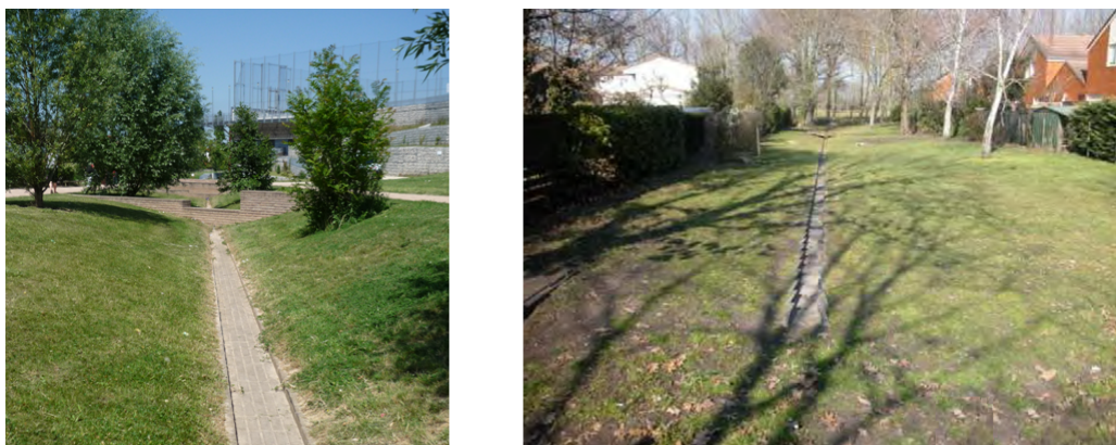
Figure 1.12 – Exemples d'ouvrages de type noues équipés de cunettes: à gauche à Chenevieux, (source : M-C. Gromaire), à droite, à Bruges (d'après CUB, 2014)
