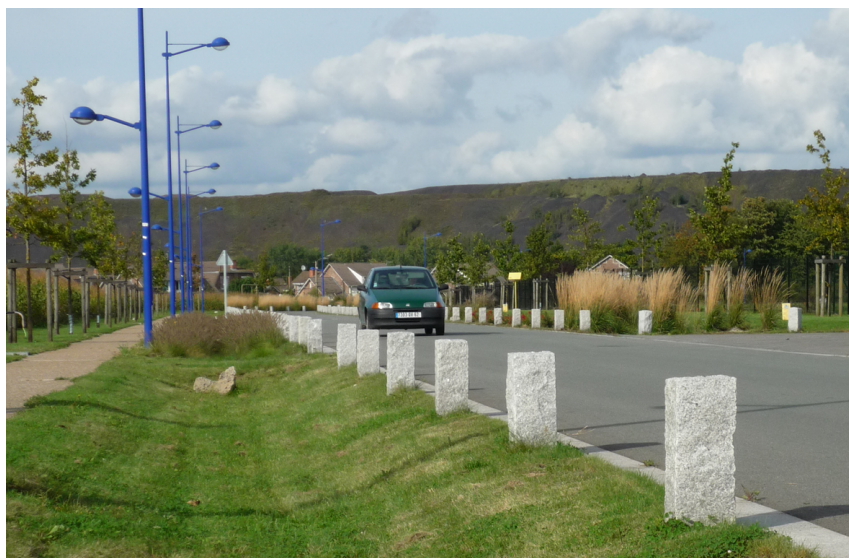
Figure 1.6 – Exemple (à Douai) d'une alimentation diffuse d'une noue par ruissellement direct depuis l'accotement d'une chaussée (Source: M-C. Gromaire)
