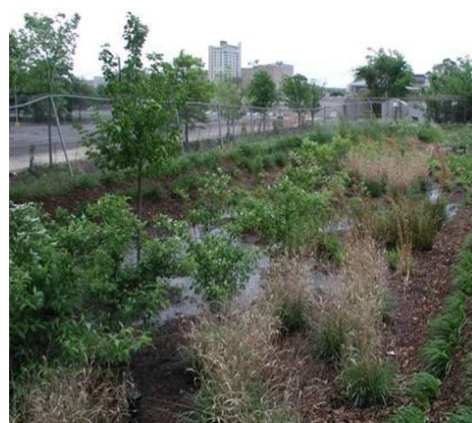
Figure 1.10 – Exemples (en Caroline du Nord) de système de « bioretention » avec stockage dans une couche de sol amendé (Source: Li et al., 2009)
