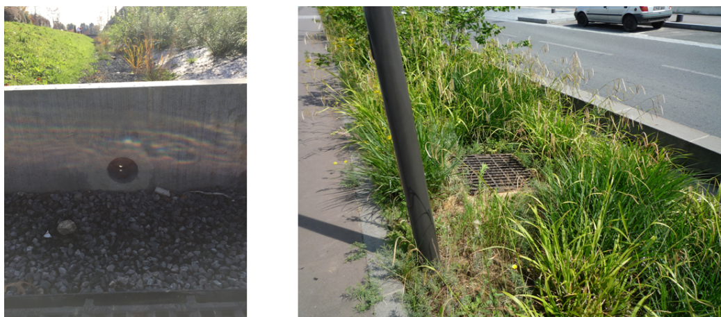
Figure 1.11 – Exemples de rejet via un dispositif de régulation (à gauche) (à Neuilly-sur-Marne) et d'évacuation au réseau en dessous du niveau du radier de l'ouvrage (à droite) (à Vitry-sur-Seine) (Source: M-C. Gromaire)
