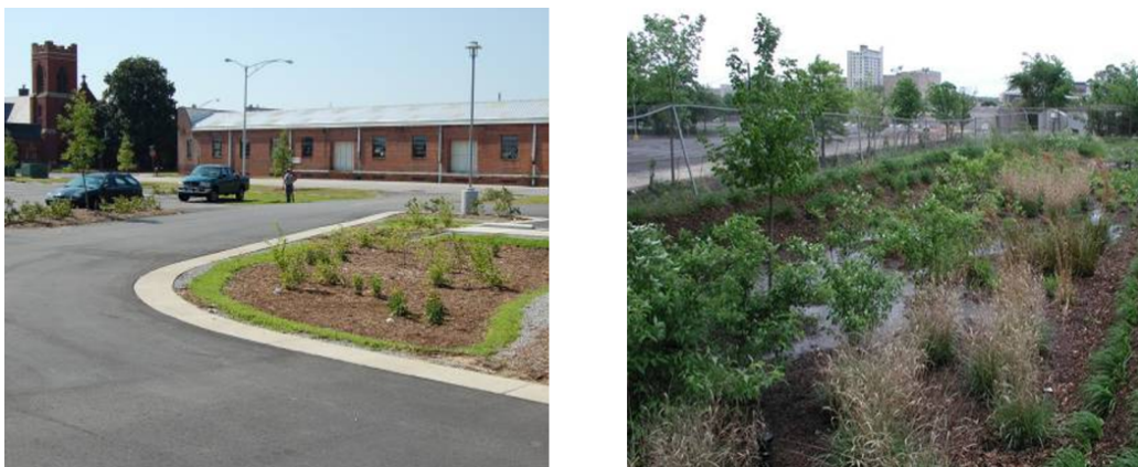
Figure 1.10 – Exemples (en Caroline du Nord) de système de « bioretention » avec stockage dans une couche de sol amendé (Source: Li et al., 2009)
