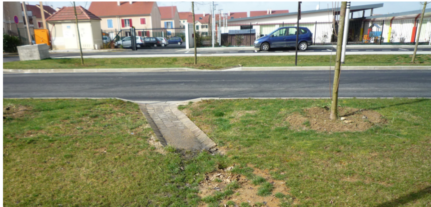
Figure 1.4 – Exemple (à Bussy St-Georges) d'une alimentation localisée depuis la surface d'une chaussée (Source: M-C. Gromaire)
