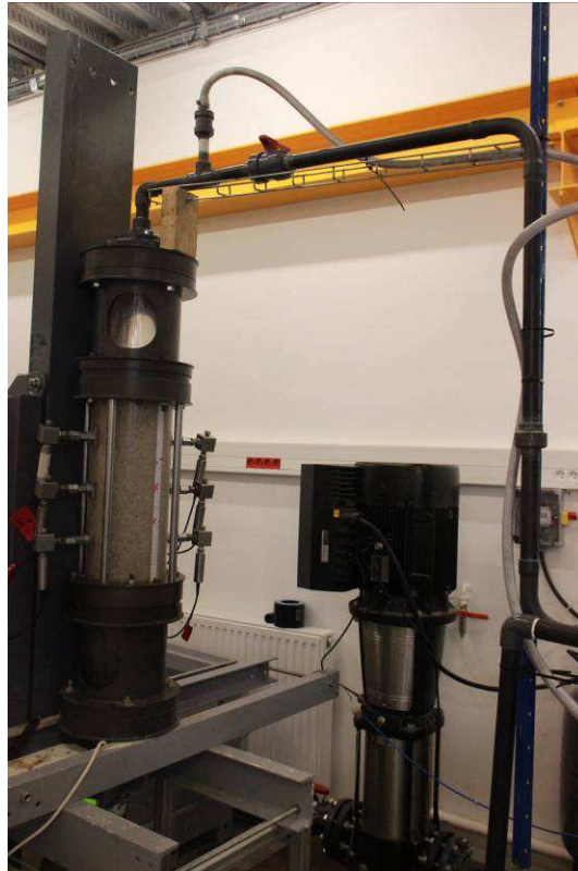
Figure II-39 Raccordement de la conduite sur le reste du circuit
