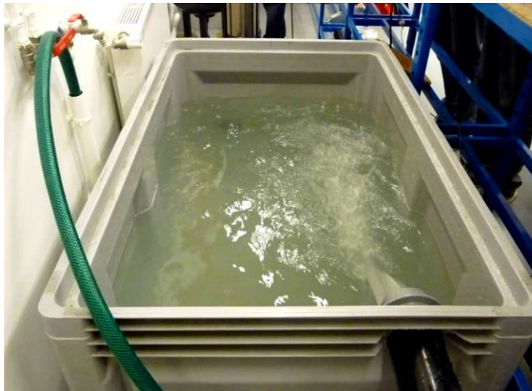
Figure II-13 Réservoir d'alimentation de la pompe
