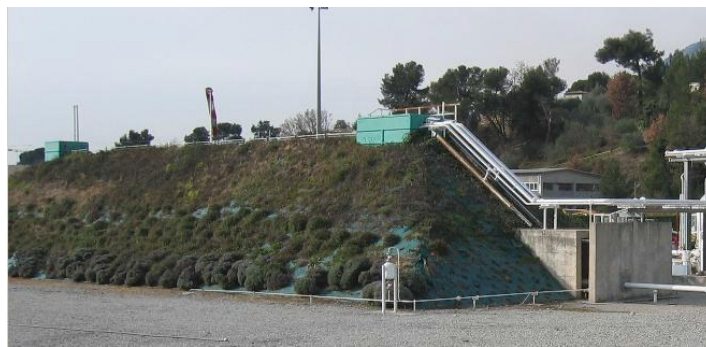
Figure 3-2 Réservoir sous talus de propane
