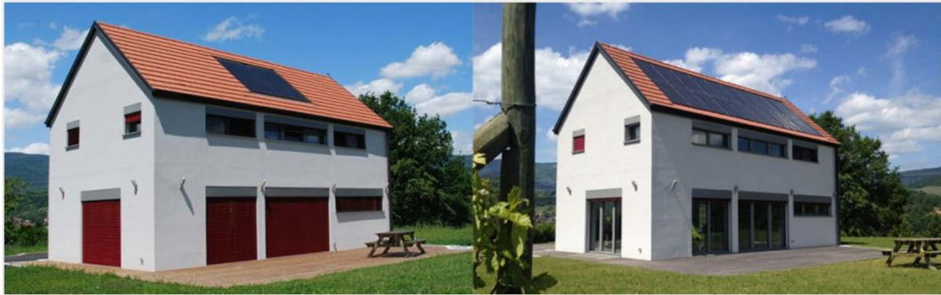
Figure 1-12. Façades « Sud » de la maison Chloé originale (gauche), et extension (droite) de la surface de panneaux photovoltaïques pour obtenir la certification « Passive House Plus », tirée de La Maison Passive (2016)
