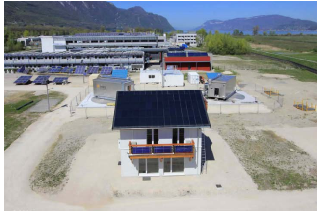
Figure 1-8. Maison I-BB de plateforme INCAS à Chambéry, source : www.cea.fr
