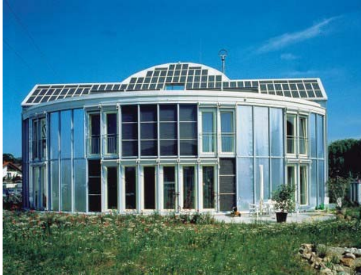
Figure 1-9. Façade sud de la maison Hölken d'après Fraunhofer-ISE (1992)
