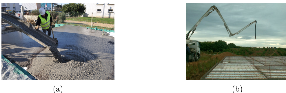
Figure 0.1 – Photos d’opérations de (a) coulage et de (b) pompage lors de la mise en place de béton.
