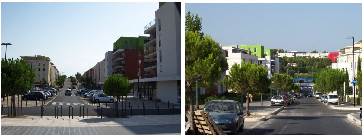
Figures A-131 et A-132. La structure orthogonale de la voirie facilite l'orientation dans le quartier. En direction de la station, l'avenue Aglaé Adanson, traversant le quartier, débouche vers cette première et permet de la percevoir à distance, ainsi que des rames de tramway en circulation. – Ce principe des vues directes est analogue dans l'autre sens, depuis la station (photos : auteur).
