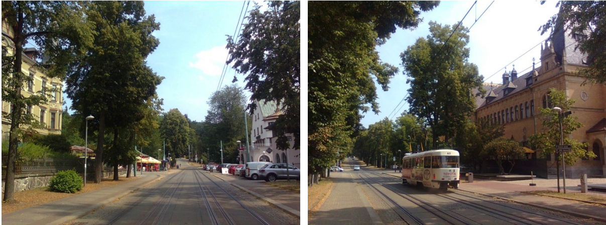
Figure 159. L'avenue du président Masaryk, dominée en termes de circulation par les tramways, aménagée en allée et bordée de part et d'autre par des palais et des hôtels particuliers, constitue un élément urbanistique unique de rayonnement sans doute dépassant la ville de Liberec (photos : auteur).
