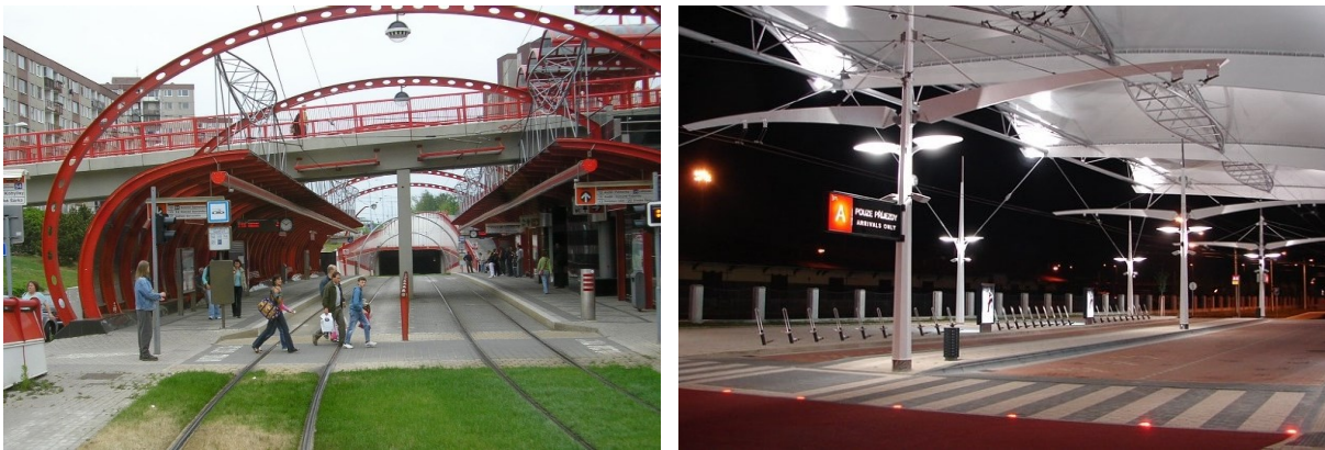
Figure 32. Parmi les nouvelles réalisations dessinées par Patrik Kotas, on peut citer l'infrastructure d'un nouveau tronçon de tramway à Prague, desservant l'ensemble de logement collectif Barrandov [nommé d'après Joachim Barrande, géologue français exerçant en Bohême au XIX e siècle] (ici la station Chaplinovo náměstí), ou un nouveau terminal de bus et de trolleybus, faisant partie du pôle d'échanges de la gare ferroviaire à Hradec Králové, métropole de la Bohême de l'Est [au début du XX e siècle communément surnommée « le salon de la République » de par les qualités de son architecture] (source : trolejbusyvpraze.net et designmagazin.cz).
