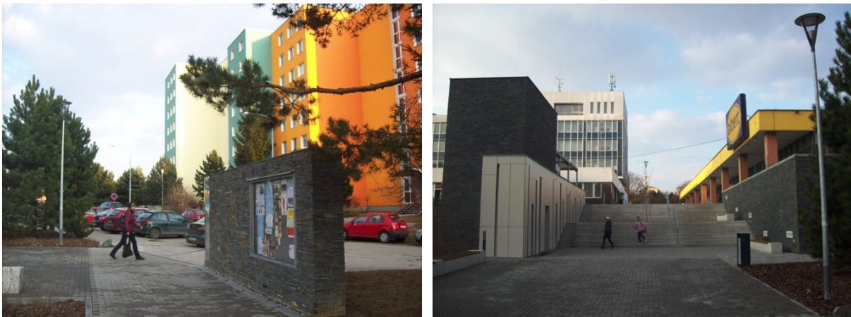
Figure 195. Les espaces publics relatifs aux abords du noyau d'équipements à proximité de la station Osová font récemment l'objet d'opération de renouvellement urbain (photos : auteur).
