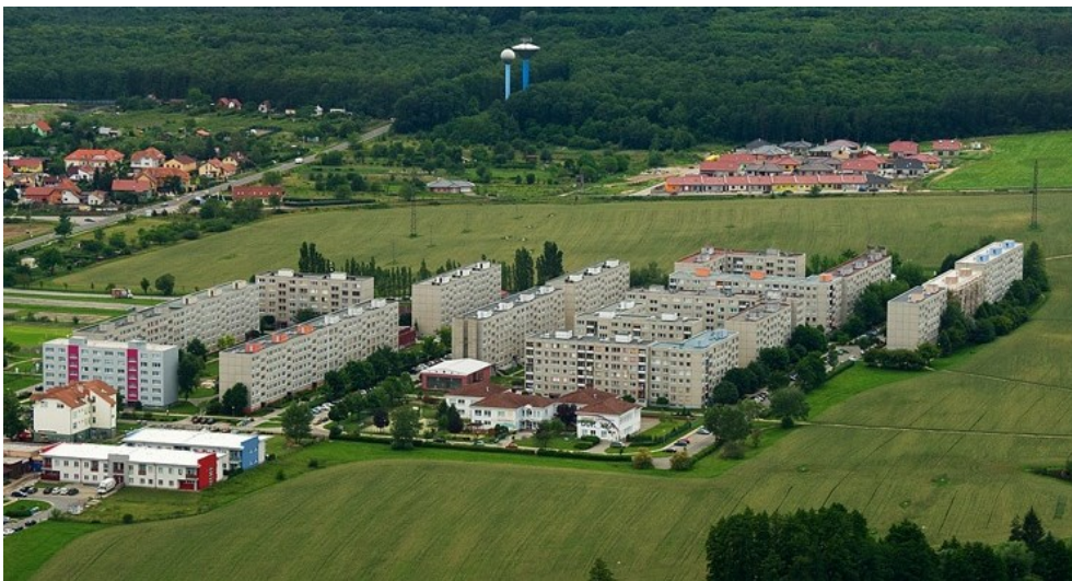
Figure 29. Une vue aérienne sur une partie de Břeclav (petite ville en Moravie) illustre bien les formes d'urbanisation caractéristiques pour les ères à la fois socialiste et contemporaine. Si les ensembles anciens de logement collectif (ici celui de Na Valtické) sont situés sur des terrains vierges, déconnectés du tissu et des infrastructures de transport existants, les ensembles nouveaux de logement individuel (familièrement appelés « ensembles allongés » en tchèque) le sont tout autant (source : janmiklin.cz).
