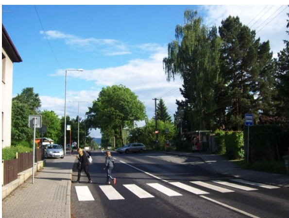
Figures A-11 et A-12. Au niveau de l'arrêt de bus, accolé à la station Kubelíkova, le passage piéton est aménagé à une extrémité des quais. – A l'autre extrémité des quais, le passage est absent (photos : S. Mermet, IFSTAR – LVMT et auteur).
