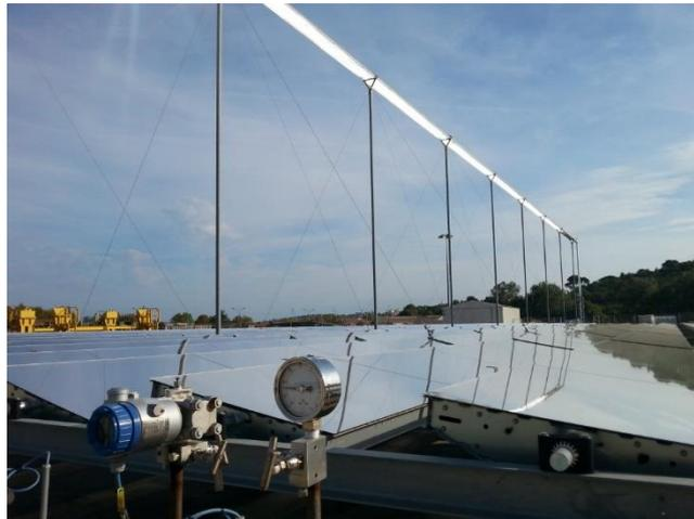
**Figure I-3 : Installation de conversion thermique du rayonnement solaire sur le site de la CNIM à La Seyne sur Mer dans le Var (Crédit : Roseline Adde-Wald).**
