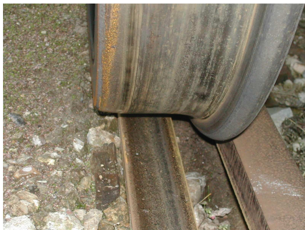
FIGURE 1.20 – Passage dans les appareils de voie
