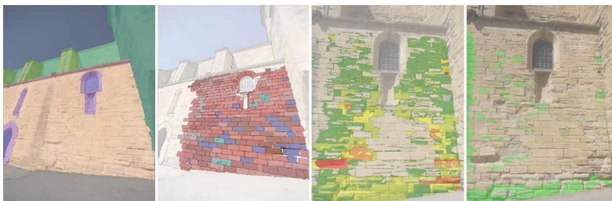
Figure 129 : Cartographies manuelles de gauche à droite : composants architecturaux, matériau bloc à bloc, perte de matière, et colonisation biologique, partie de la façade Est de l'église Saint Maurice. [Benard A., 2015].
