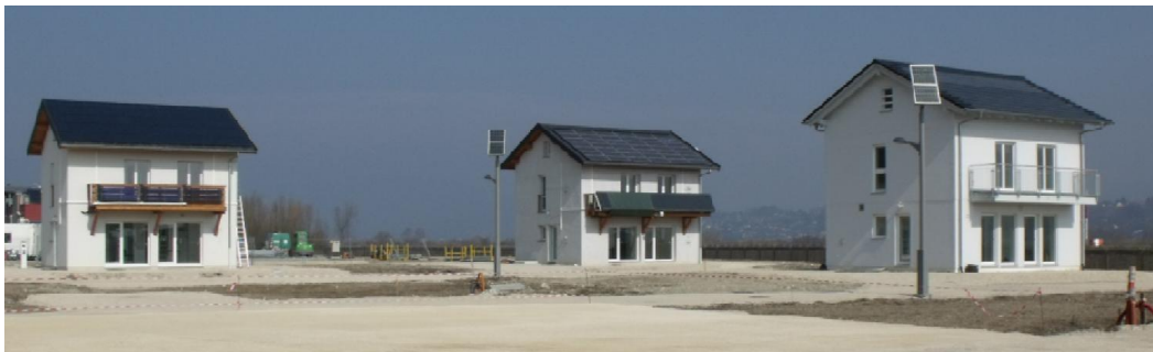
Figure 67 : Photo des trois premières maisons construites sur la plateforme INCAS
