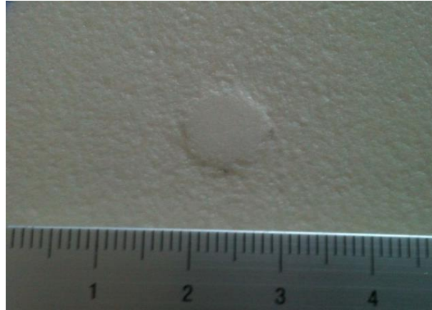
Figure 12 : Défaut de gouttes sur un produit fini
